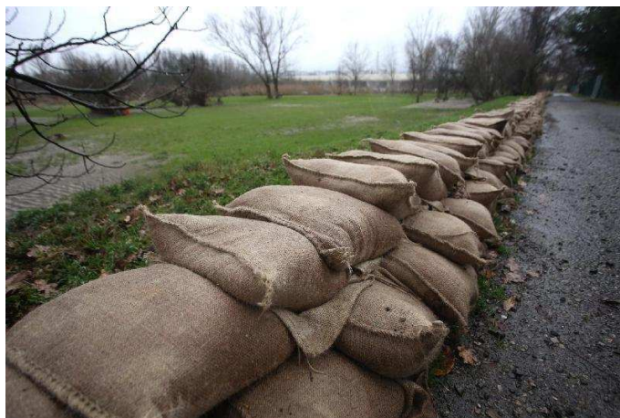
Barriera di sacchetti a protezione sede stradale
